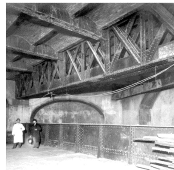
Place de l'Opéra : chantier très technique de l'ouvrage de superposition des trois lignes (mars 1904)
