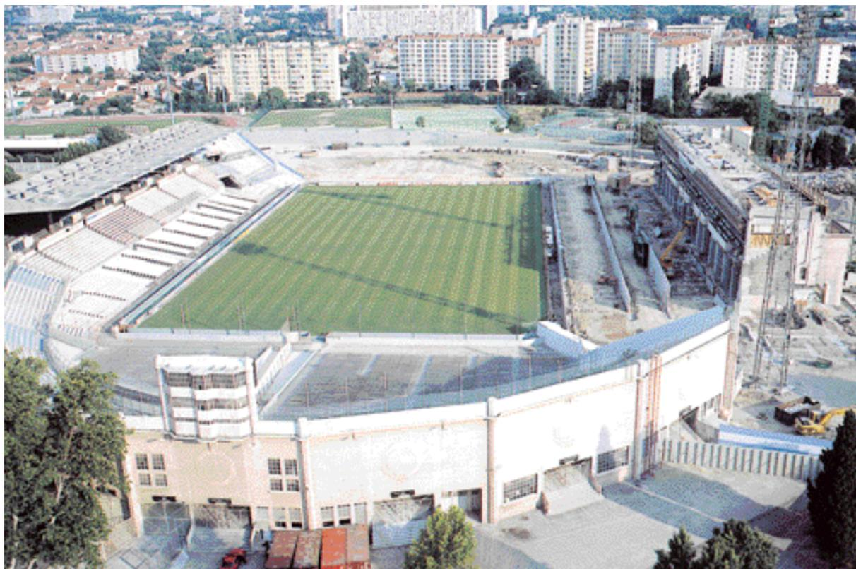
Rénovation du Stade Vélodrome de Marseille (1996-1997) : la capacité d'accueil passe de 40.000 à 60.000 places et va nécessiter la construction de 32 kilomètres de gradins
