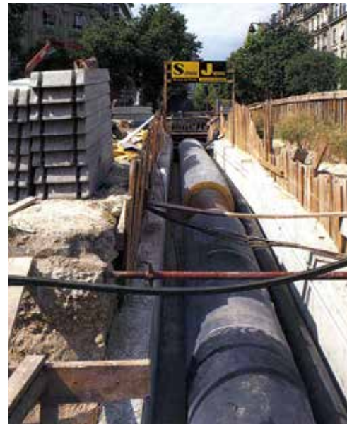
Franchissement d'une galerie SNCF sur le terre-plein de la place Wagram à Paris.
