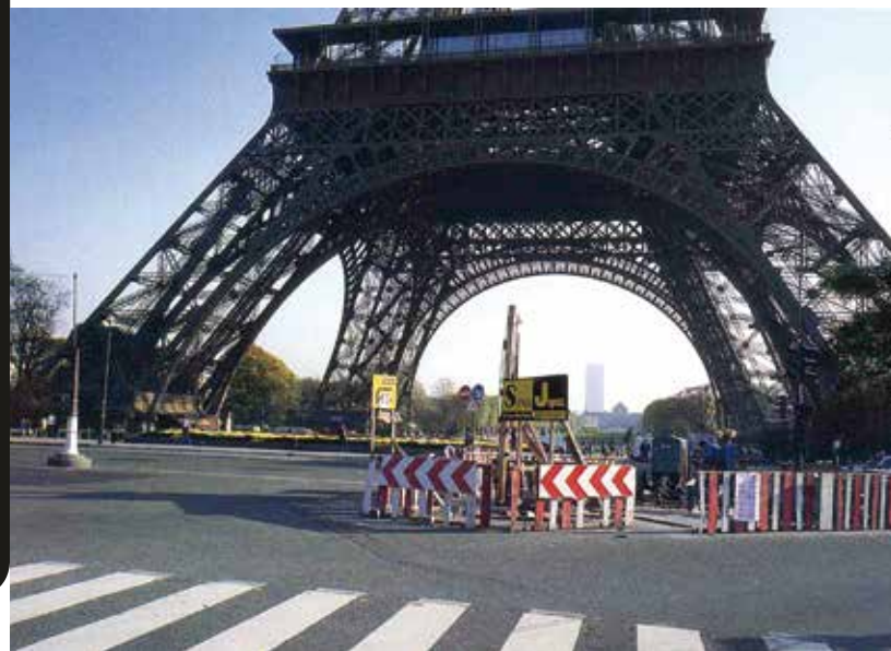
Travaux de chauffage urbain effectués pour la Compagnie Parisienne de Chauffage Urbain (CPCU).
