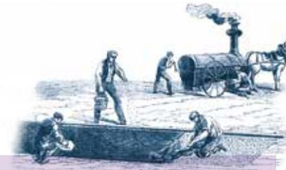
De nouveaux engins mécaniques sont mis en service pour le transport et la manipulation des matériaux ainsi que des machines à vapeur pour assécher les sous-sols inondables. L'emploi de l'air comprimé fait évoluer les techniques de construction. L'emploi de bâches imperméables permet la construction en plein hiver. **Autre exemple, le travail des paveurs est transformé par l'utilisation du macadam à l'eau et l'emploi du bitume.**
