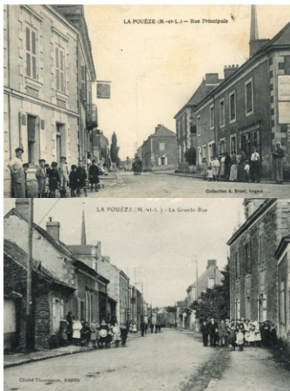
Le bourg de La Pouéze, au nord-ouest d'Angers, est électrifié avant la Première Guerre mondiale : la Grande Rue, avant et après l'installation des réseaux.
