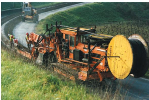
Une trancheuse et dérouleur de câble, en action (années 1980). Sous l'impulsion de Christian Martin, les relations entre le Syndicat et EDF s'améliorent et se matérialisent sur le terrain. EDF et le SIÉML installent de nouveaux transformateurs et conduisent des travaux d'amélioration du réseau, comme ici, à Saint-Aubin-de-Luigné, dans la vallée encaissée du Layon.
