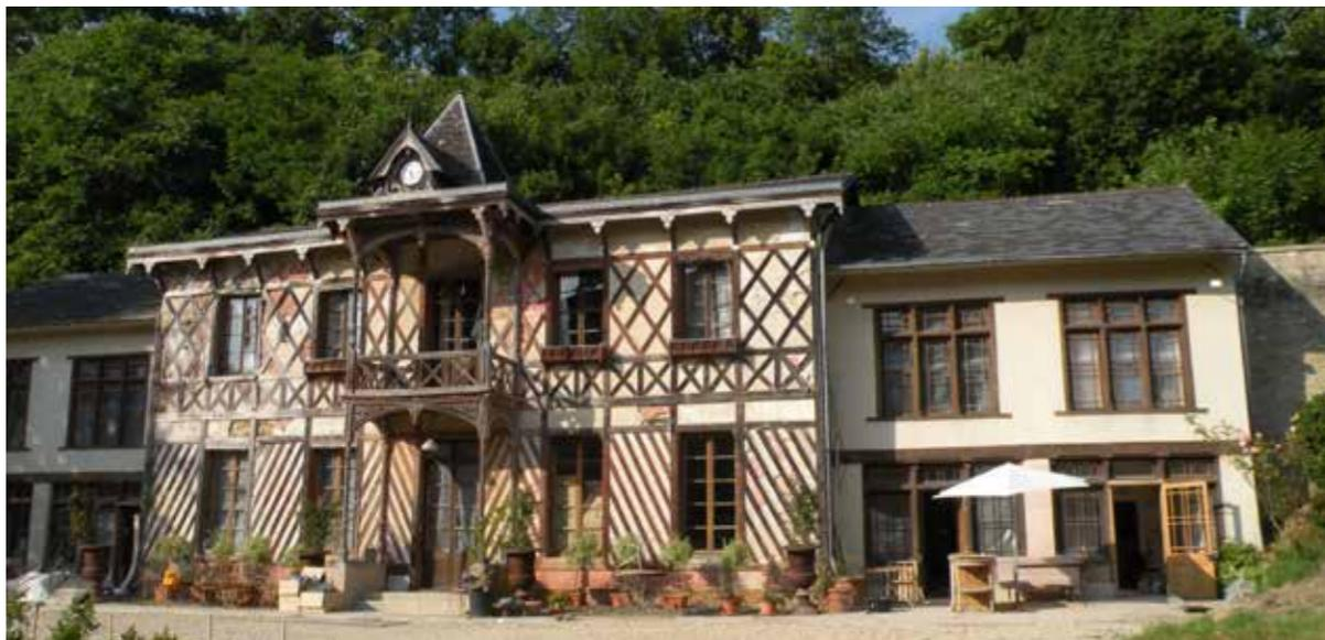
Le pavillon-bibliothèque du château de la Bûcherie possède une façade de cinq travées sur un étage. Sa particularité réside dans son décor en pans de bois disposés de façon diagonale au rez-de-chaussée, et formant des losanges à l'étage. La porte, au milieu, est surmontée par un balcon en bois accessible depuis l'étage et couvert par un petit toit aigu agrémenté d'une horloge.
