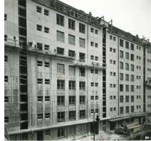
↑ La pose du revêtement de façade au 9, rue Boussingault, 1954. Les cadres des fenêtres et de la cage d'escalier ne sont pas encore posés.
